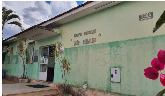
Figura 4 - Fachada Interna da Escola Estadual João Beraldo 6
